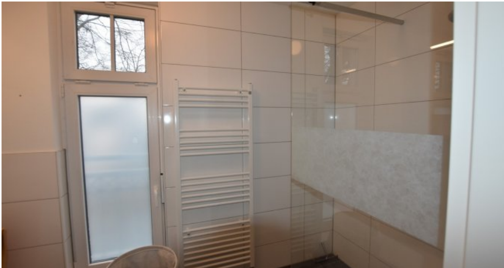
OG Koppelzimmer Bad
