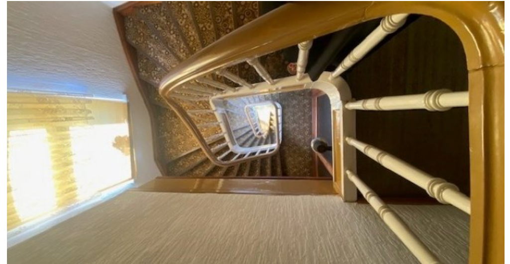
Wilster Treppenhaus gesamt
