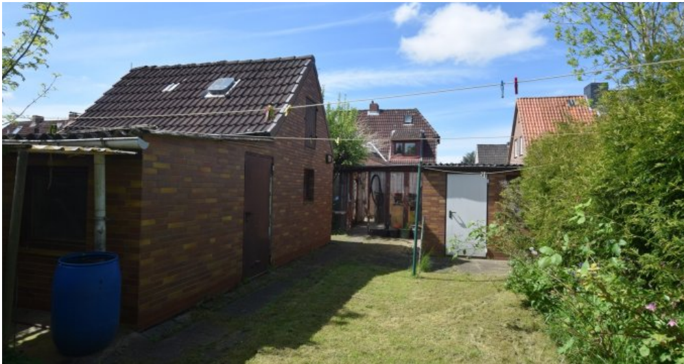
Ansicht rückseitig Haus
