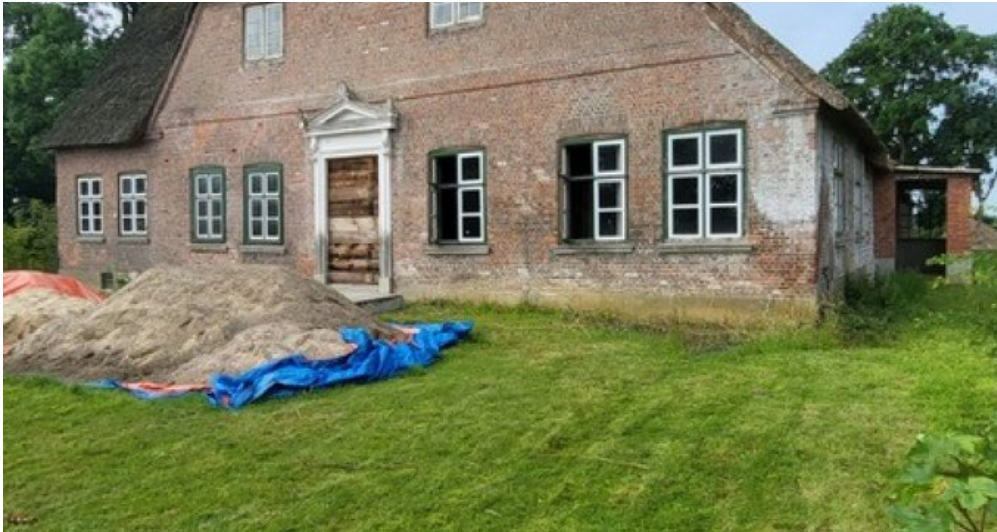
Eingang 2. Ansicht Sommerland
