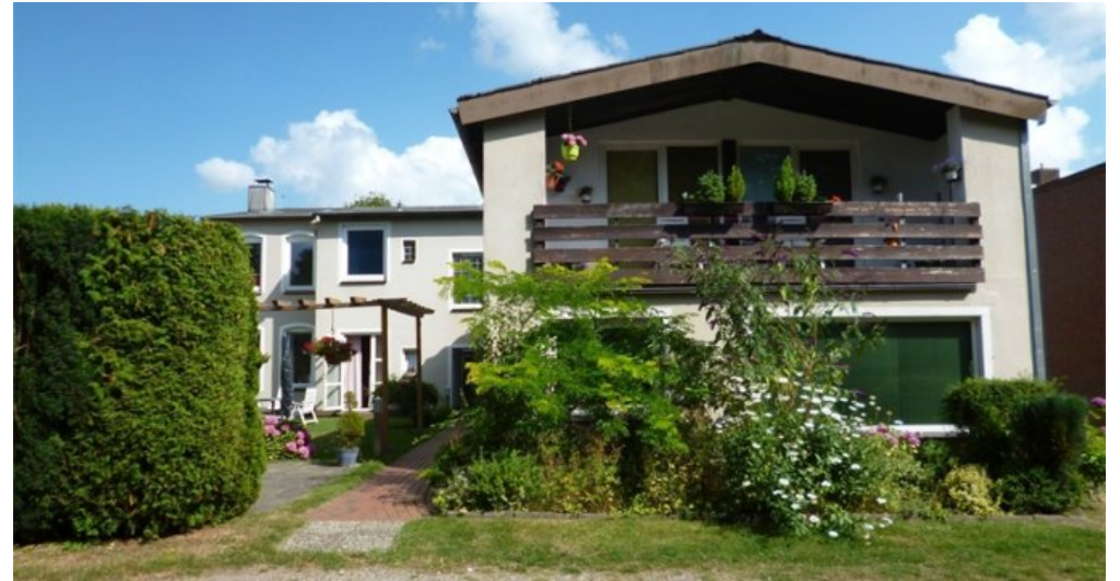
Haus mit Anbau
