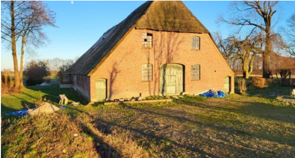
Toreinfahrt Hintere Ansicht So
