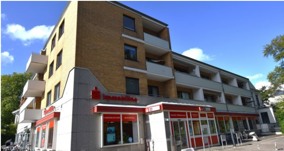
Ansicht v Parkplatz bearb
